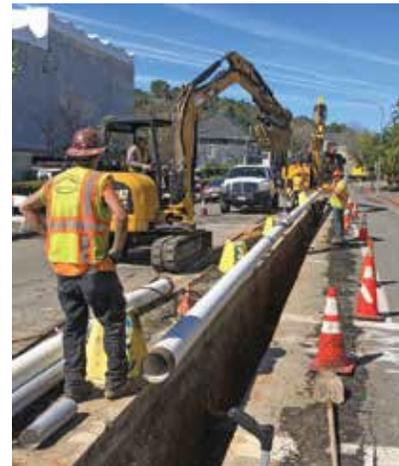
En un proyecto de tuberías de 2022 en Third Street, en San Rafael, se reemplazaron unos 2,000 metros de tuberías de hierro fundido de 95 años de antigüedad con tuberías nuevas de acero soldado. El ajuste de tarifas propuesto aumentará la cantidad de tuberías envejecidas que Marin Water pueda reemplazar al año
