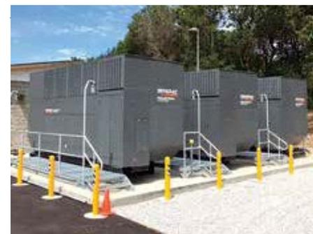
Se instalaron tres generadores de emergencia permanentes en la planta de tratamiento de San Gerónimo en 2022 para garantizar la continuidad del servicio de suministro de agua a los clientes en caso corte de energía. La propuesta de tarifas permitirá realizar mejoras adicionales en la confiabilidad del sistema de agua.
